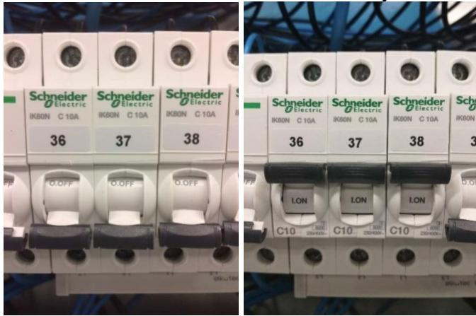
Kuvassa vasemmalla oleva johdonsuojakatkaisija on OFF-asennossa, jolloin sähkö ei kulje sen läpi. Kuvassa oikealla oleva johdonsuojakatkaisija ON-asennossa, jolloin sähkö kulkee johdonsuojakatkaisijan läpi ja katkaisijan takana olevat laitteet tai kojet ovat sähköistettyjä.
