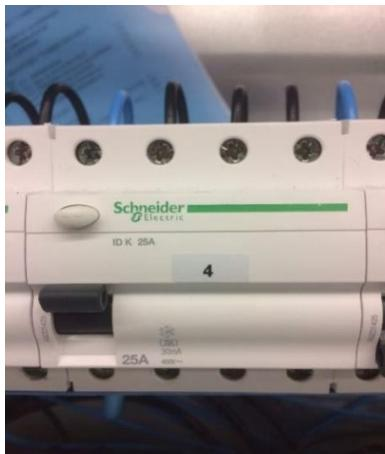
Kuva: Vikavirtasuojakatkaisija on I-asennossa ja laskee sähkön läpi johdonsuojakatkaisijoille sekä on toimintavalmiina tunnistamaan mahdollisen vian sähköjärjestelmässä.
