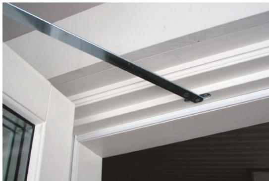
Aukipitolaitte toimii oven painikkeesta. Avatkaa ovi haluamaanne tuuletusasentoon, käänämällä painikkeesta (kuva 1) ovi lukittuu paikoilleen eikä tuuli paiskaa ovea kiinni kovemmallakaan tuulella. Jos painike on auki asennossa (kuva 2) ovi liikkuu vapaasti.
