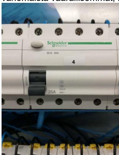
Kuva: Vikavirtasuojakatkaisija on O-asennossa. Tässä asennossa vikavirtasuoja on toiminut, eikä laske läpi sähköä johdonsuojakatkaisijoille.
